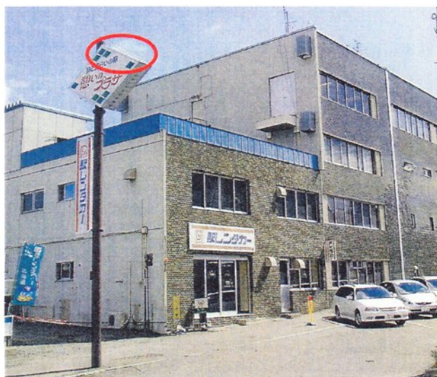
落下した電球の取付位置
